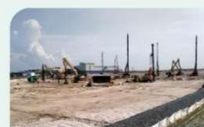
建設現場（2025年6月時点）
