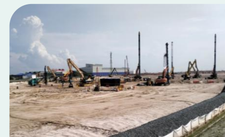
建設現場 (2025年6月時点)
