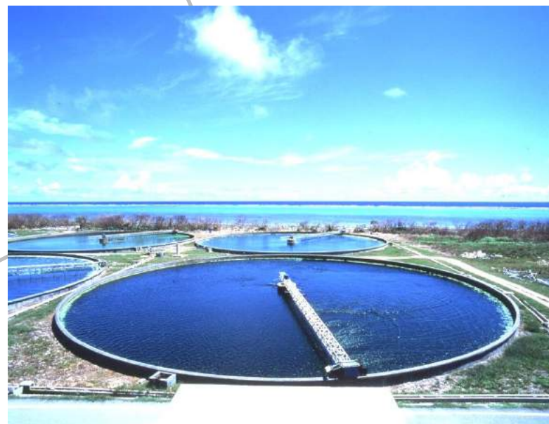
2005年当時の設備(現在は違う設備) @ 沖縄県石垣島
