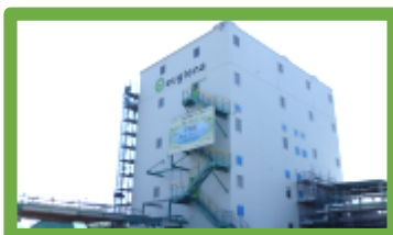
建設現場の様子 2018年4月時点
