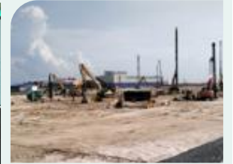
Construction site (Jun. 2025)
