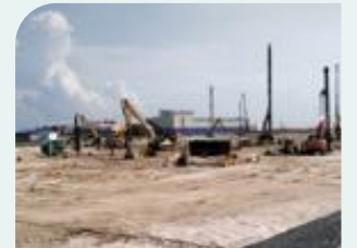
建設現場 (2025年6月時点)
